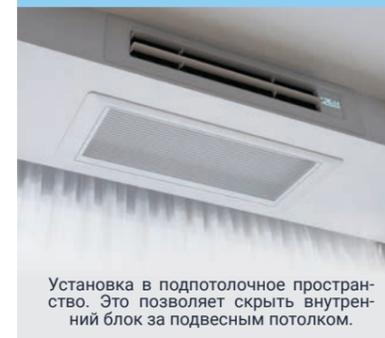
Установка в подпотолочное пространство. Это позволяет скрыть внутренний блок за подвесным потолком.
