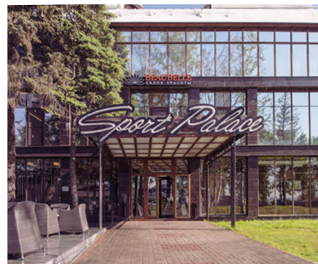
Фитнес-центр «Sport Palace», г. Санкт-Петербург
