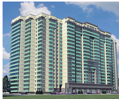
Жилой дом, г. Шушары
